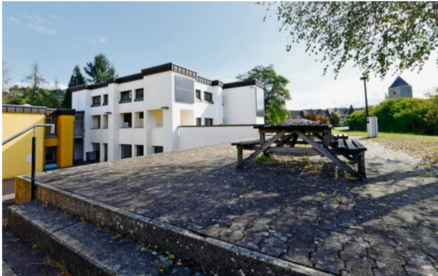
Dass im leer stehenden Schulhaus Blöleboden ein Asylzentrum entstehen könnte, löst nicht nur bei manchen Kaiserstuhlern Ängste aus. Auch in Weiach verfolgt man das Geschehen genau.
